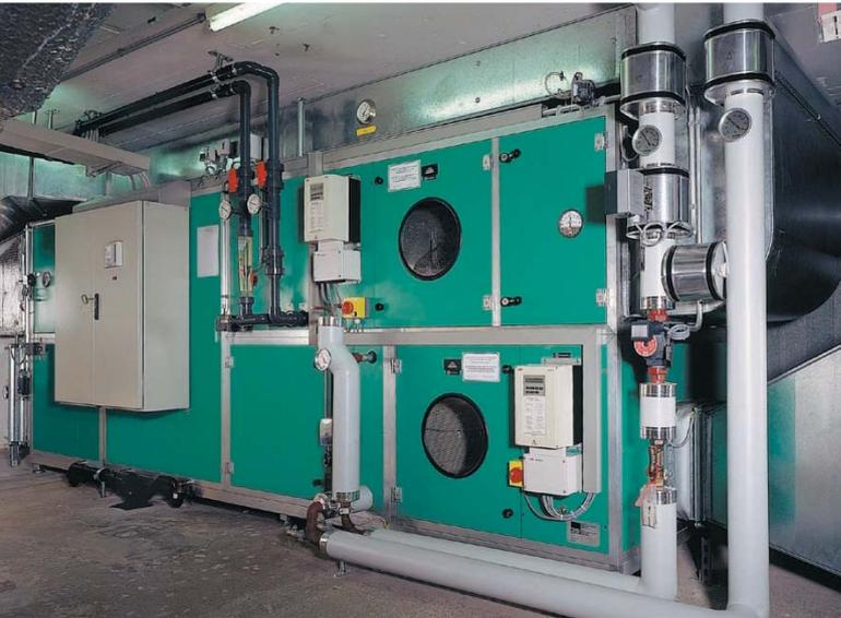
ECOPOOL ist ein anschlussfertiges System-Klimagerät für jegliche Art von Hallenbädern und garantiert ein behagliches und konstantes Klima. Die mit Wasserdampf angereicherte Hallenluft wird nach Bedarf entfeuchtet und beheizt. Für die Erneuerung der Hallenluft sowie bei hohem Feuchteanfall, z.B. bei einem regen Badebetrieb, wird ein definierter Aussenluftanteil beigemischt.
