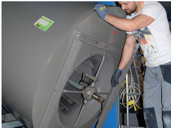
Alter Gehäuseventilator wird ausgebaut und...
